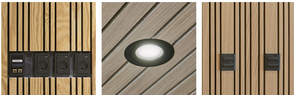
Figur 12 Indbygning af installationer
